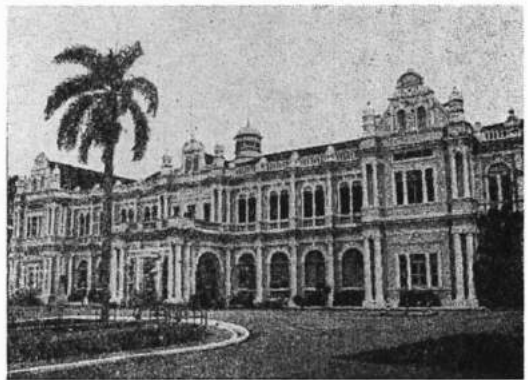
写真—3 シティホール
