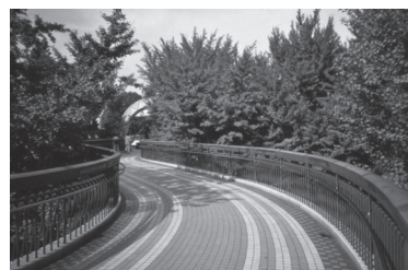
写真4 S字を描くポーリン橋
