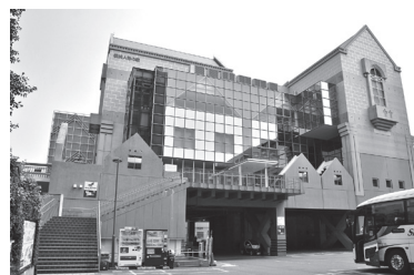
写真2 デッキの上に建つ
