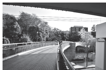
写真5 カーブを描くフランス橋
