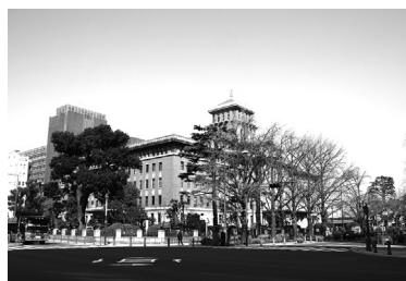
写真8 神奈川県庁本庁舎
