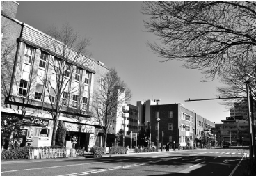
写真10 海岸通り沿いの事務所建築
