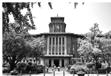
写真9 神奈川県庁本庁舎
