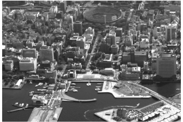
写真10 2010(平成22)年の「象の鼻地区」(写真提供:横浜市)
