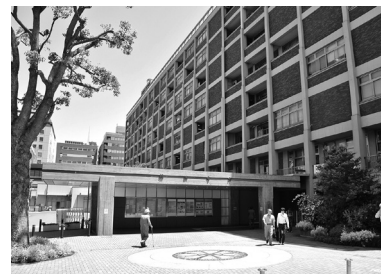
写真6 改修され設けられた小広場と玄関ポーチ。
