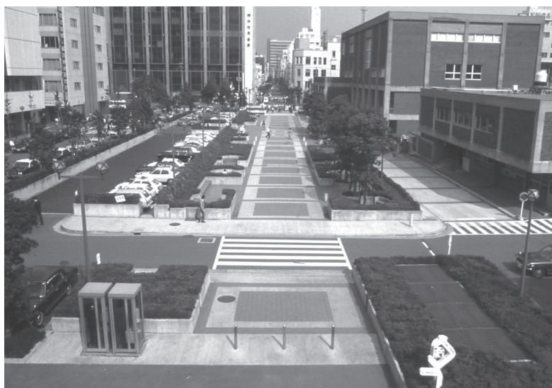
写真2 完成後間もない頃の「くすのき広場」
