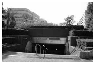
写真8 道路との立体交差を兼ねた「地下鉄入口」
