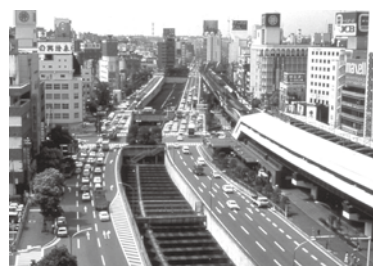
写真1 地下に潜った高速道路。右側はJR関内駅
