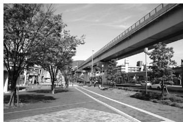
写真12 高速道路の高架橋は暫定2車線で造られ、将来両側に1車線ずつ増設して4車線になる予定
