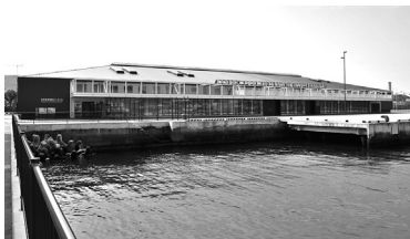
写真16 古い倉庫をリノベーションした佐世保港国際ターミナル「葉港テラス」
