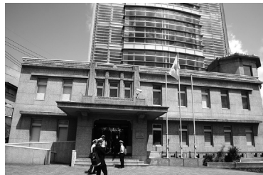
写真7 セイルタワー低層部の旧佐世保水公社
