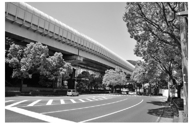
写真9 国際通りと高架の高速道路
