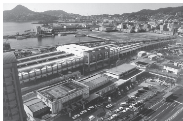
写真2 「佐世保駅」旧駅舎と国道。港側に高架の新駅舎が完成している（佐世保市パンフレットより）
