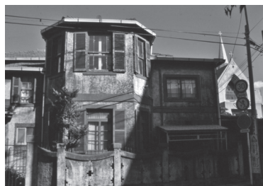
写真5 旧カトリック山手教会司祭館
