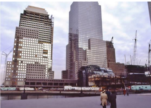
建設中のバッテリーパークシティ
