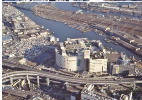
竣工当時の「横浜新都市ビル」とその周辺地区
