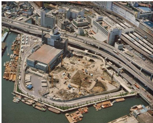
着工前の現場（1983 年 9 月）
