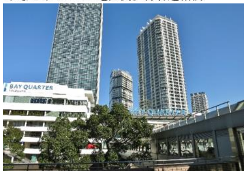
ポートサイド地区側歩行者連絡橋
